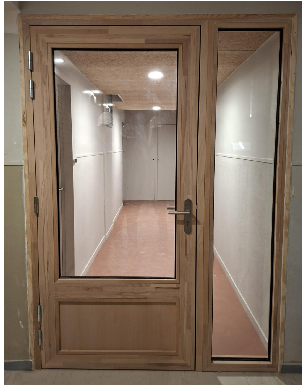
exemple de porte cf vitrée
