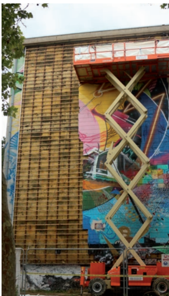
Déconstruction du 1, 3, 5 rue de la Marbaudais
