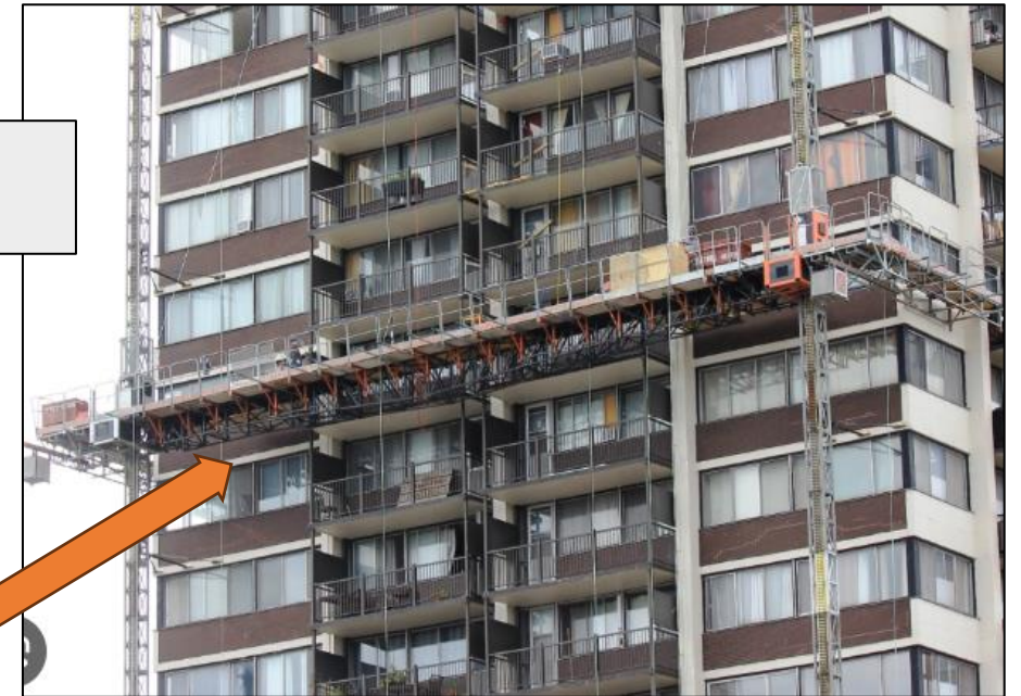
Ascenseurs de chantier sur les façades NORD (compagnons + matériaux)
