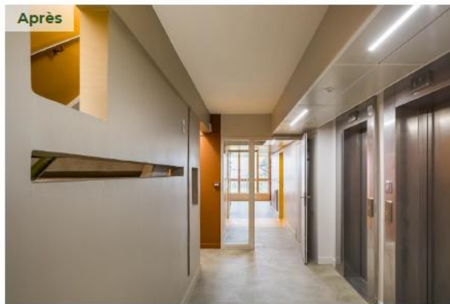
Ouverture et éclairage naturel des paliers
