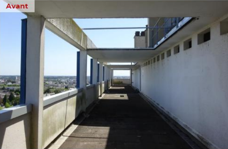
Avant : Greniers et coursives
